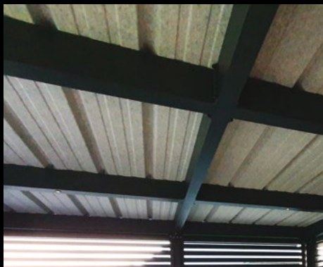
Toiture bac acier
